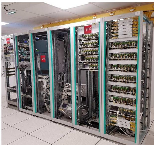
*Point névralgique du réseau fibre, la tête de réseau, située dans le centre-ville de la Roche sur Yon concentre l'ensemble des équipements permettant de déployer la fibre optique dans l'agglomération*
