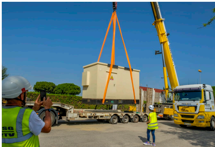
Pose du NRO à Vauvert en juin dernier
