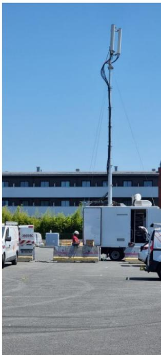
L'antenne mobile d'urgence, de 10 mètres de hauteur, est installée à proximité immédiate du lieu d'hébergement des personnes évacuées et permet aux clients SFR de pouvoir communiquer sur les réseaux 3G, 4G et 4G+ ; elle permet également aux Services Départementaux d'Incendie et de Secours présents sur place de maintenir les communications d'urgence.
